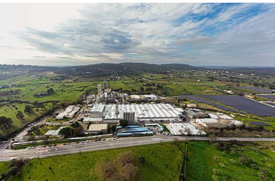
Le site de Portalegre, qui regroupe le recyclage, la production de résines et l'extrusion de films, est équipé d'une large surface de panneaux photovoltaïques.
